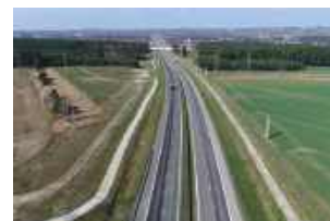
Miejsca Obsługi Podróżnych Jezierznia Wschód i Zachód będą zlokalizowane na obwodnicy Tomaszowa Lubelskiego w ciągu drogi ekspresowej S17. Fot. GDDKiA
