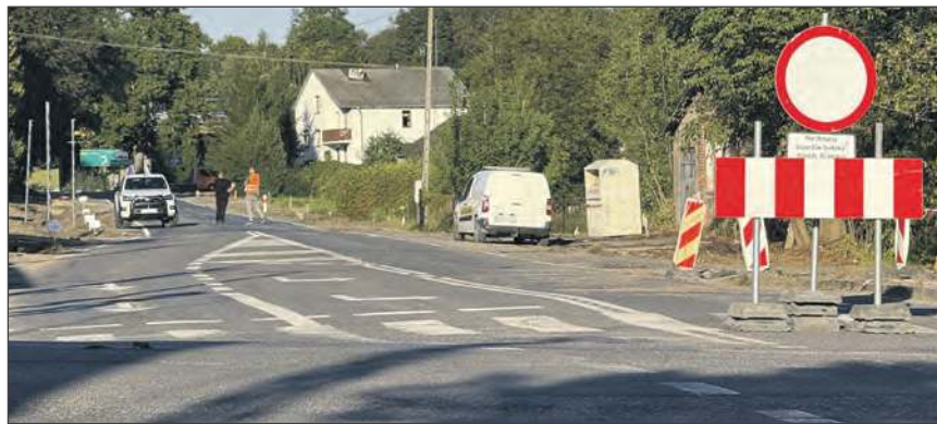
☛ Droga na czas remontu została zamknięta
