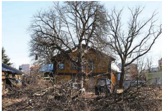
Wycinka drzew pod Osiedle Muzyczne przy ul. Paderewskiego
