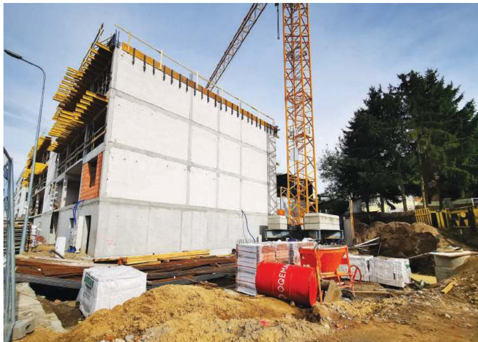
I etap budowy Apartamentów Warszawska 24
