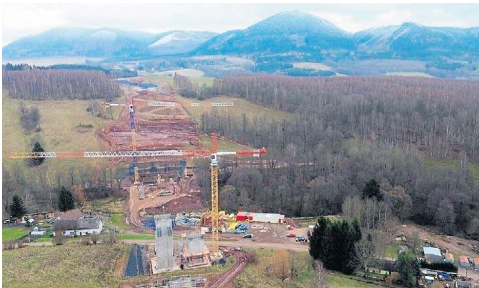
Budowa mostów i wiaduktów w pobliżu miejscowości Bernartice. Na tym odcinku D11 pracują już potężne żurawie, powstają pierwsze betonowe konstrukcje - podpory przyszłych wiaduktów.
