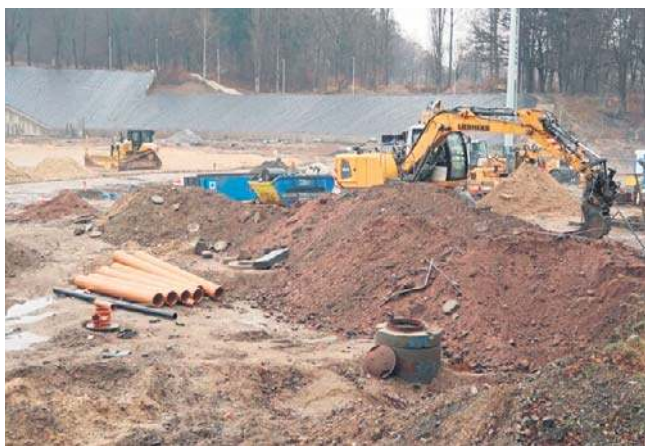
Plac budowy w grudniu 2025
