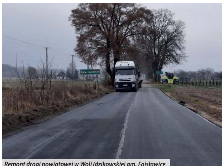
Remont drogi powiatowej w Woli Idzikowskiej gm. Fajslawice
