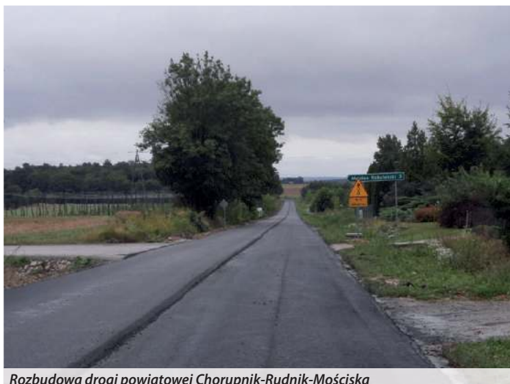
Rozbudowa drogi powiatowej Chorupnik-Rudnik-Mościska
