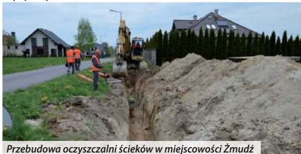
Przebudowa oczyszczalni ścieków w miejscowości Żmudź
