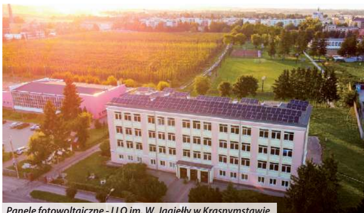
Panele fotowoltaiczne - I LO im. W. Jagiełły w Krasnymstawie
