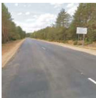
Przebudowana droga Nr H-424 po stronie białoruskiej
