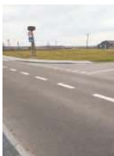
Przebudowana droga powiatowa nr 1051L
