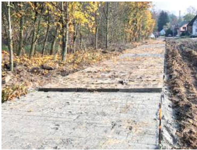
W Rogalowie na podbudowie betonowej zostaną ułożone płyty
