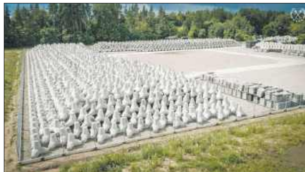
Przy granicy powstają tereny magazynowania wojskowych środków inżynieryjnych. Największy będzie miał 20 ha powierzchni i powstanie w Białej Podlaskiej (zdj. przykładowe)
