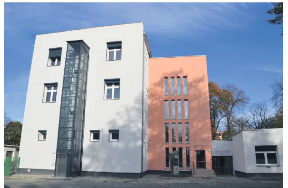
Termomodernizacja budynku B CKZiU w Strzelinie
