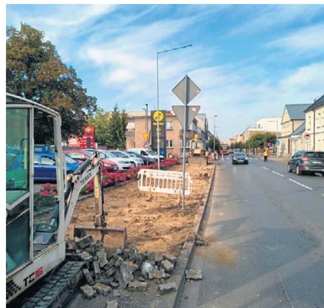
Przebudowane zostaną m.in. nawierzchnia jezdni, chodniki i zjazdy
