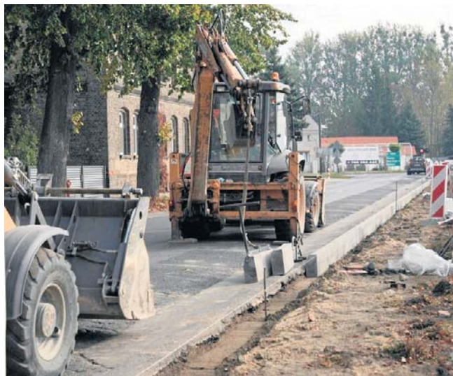
Trwa budowa nowego chodnika przy dworcu PKP w Zbąszyniu. Inwestycja, jak zapewniono, ma poprawić komfort i bezpieczeństwo pieszych
