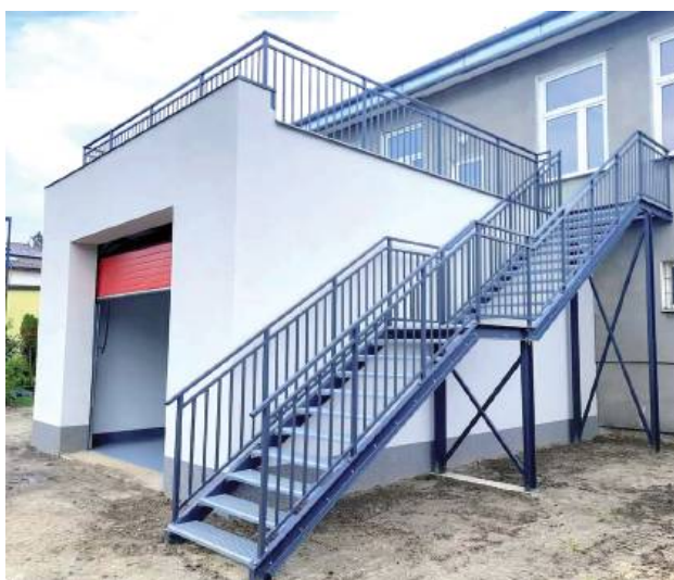
Tylna część budynku OSP w Gołębiu teraz wygląda inaczej. Poza modernizacją garażu, wykonano także schody oraz taras
