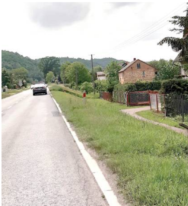
Mieszkańcy Parchatki od lat proszą o budowę chodnika w swojej miejscowości. Powoli powstają kolejne jego metry. W tym roku ZDW chce zbudować kolejne, dzięki czemu piesi będą mogli poruszać bezpiecznie
