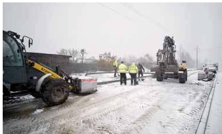
Modernizacja ul. Opinogórskiej w Ciechanowie
