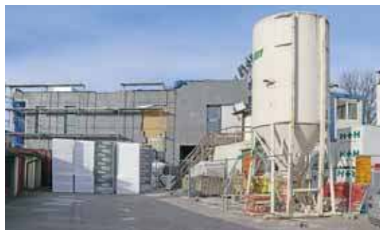
Tak wygląda obecnie plac budowy CO-M
