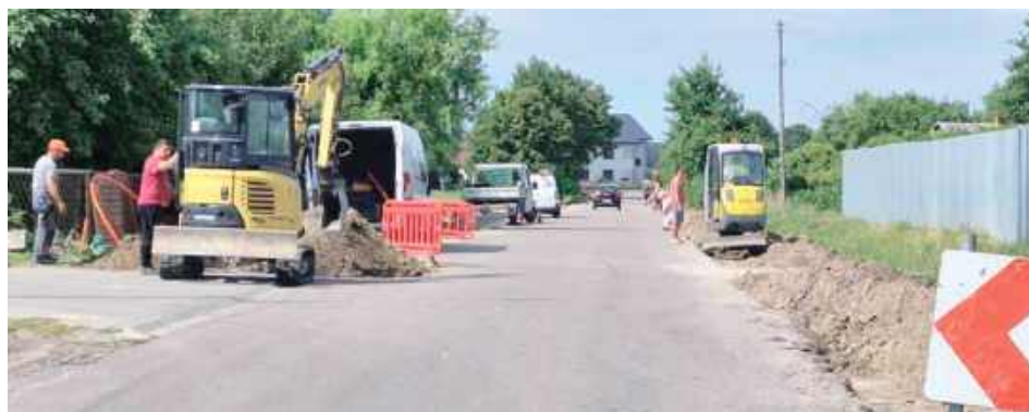
Całkowita wartość inwestycji to 9 048 077,33 zł
