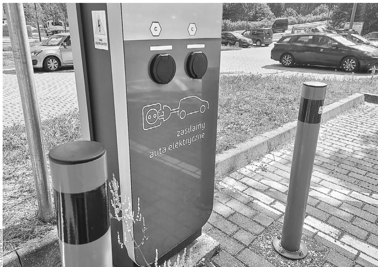
Infrastruktura do ładowania elektryków jest coraz lepsza
