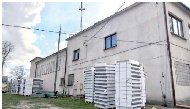
Jednym z termomodernizowanych budynków jest urząd gminy. Obecnie są w nim wymieniane źródła światła, a stropodach jest ocieplany styropianem
