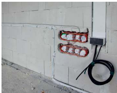
🔧 Instalacje układa się przed zrobieniem tynków i wylewek. J. WERNER
