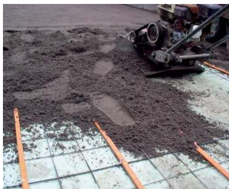
🔧 Układanie instalacji przeciwooblodzeniowej na podjeździe. Pod płyty betonowe lub kostkę kable układa się w warstwie podsypki. NVENT THERMAL
