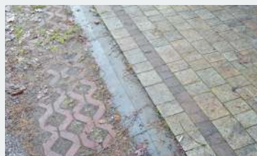
Na styku asfaltowej drogi ułożono – ażurowe płyty, ukośną wylewkę betonową hamującą napływ wody z ulicy.
