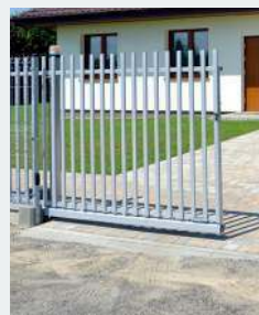
➤ Na połączeniu ulicy i podjazdu ułożono grube płyty z betonu.
