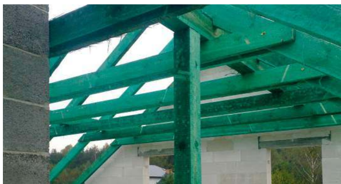
📍 Konstrukcja więźby najczęściej jest wykonywana na budowie przez cieśli. T. RYBARCZYK
