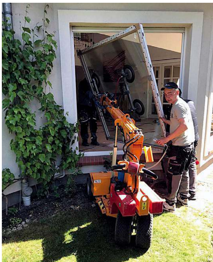
Wymiana okien z użyciem specjalnego podnośnika do szkła. MS WIĘCEJ NIŻ OKNA
