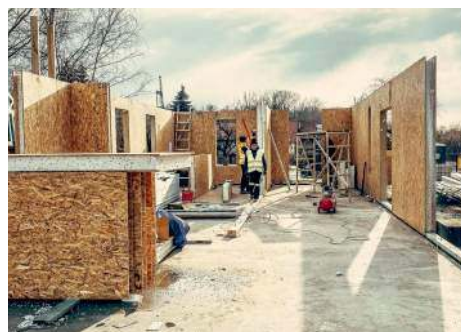
📍 Domy modułowe z paneli SIP, czyli z grubych płyt wypełnionych pianką poliuretanową, są energooszczędne, wytrzymałe i bardzo szybko się je buduje. SIP PANEL POLSKA
