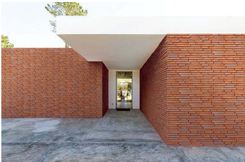
🔧 Ściana dwuwarstwowa wykończona okładziną z płytek. STEGU
