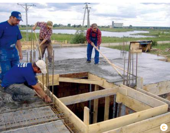
📍 Poszczególne etapy układania stropu gęstożebrowego: rozmieszczenie pustaków na belkach stropowych (a), rozłożenie siatki stalowej (b), zalanie stropu mieszanką betonową (c). RECTOR
