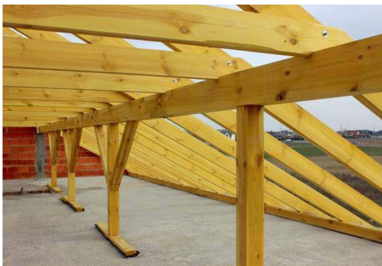
Prefabrykowane więzary wytwarza się w wyspecjalizowanych fabrykach, nie na placu budowy. Słupy, w konstrukcji płatwiowo-kleszczowej, utrudniają zagospodarowanie poddasza. GRUPA BURKIETOWICZ
