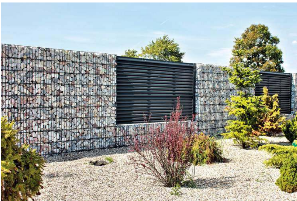
🔧 Gabiony, czyli kosze wypełnione z reguły kamieniami, to konstrukcje samonośne, nie wymagające fundamentu. KONSORT
