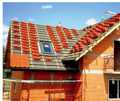
🔗 Dachówki układa się, zaczynając od okapu. RÖBEN
