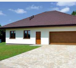
➤ Kostkę z betonu dobrano kolorystycznie do wykończenia budynku.
