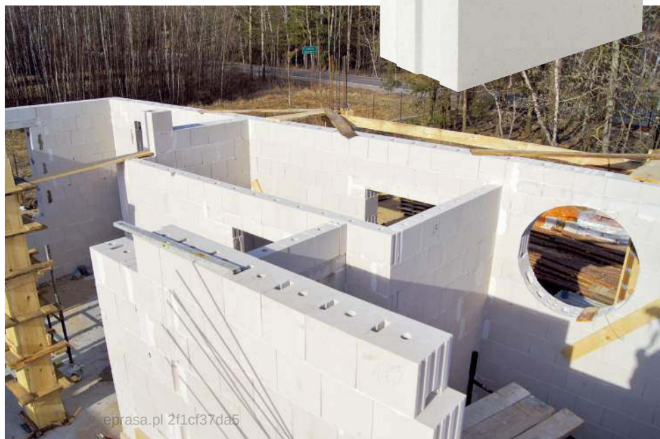
🕒 Białe bloczki silikatowe robi się z piasku, wapna i wody. Mają fabrycznie wykonane otwory, by były lżejsze. Są bardzo wytrzymałe, ale ich cięcie jest pracochłonne. H+H
