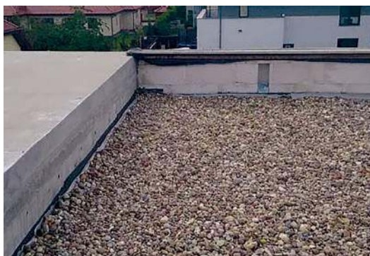
➦ Żwir wysypany na geowłókninie stanowi warstwę dociskową i chroni przed przegrzewaniem wnętrza.
