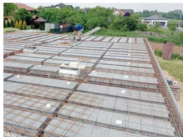
📍 Stropy gęstożebrowe z lekkich pustaków keramzytobetonowych układa się na belkach rozmieszczonych co 45–60 cm. CZAMANINEK
