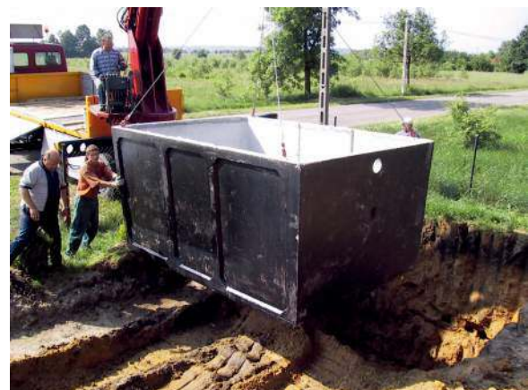
➔ Szczelne szambo to najczęstszy wybór, gdy dom nie ma dostępu do kanalizacji miejskiej czy gminnej. PROBUD
