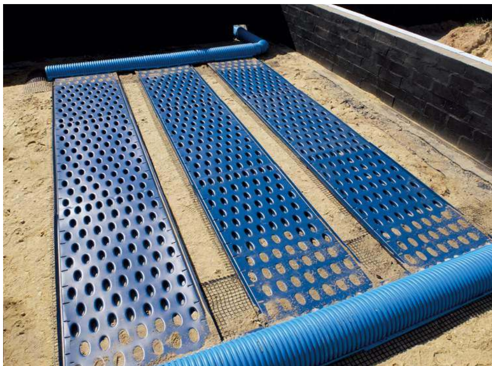
🔹 Połączenie rekuperacji z gruntowym wymiennikiem ciepła pozwala zwiększyć efektywność systemu wymiany powietrza. PRO-VENT
