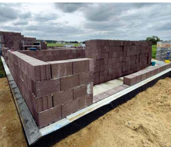
🕒 Keramzytobeton jest mało nasiąkliwy. Ulewa w trakcie budowy nie będzie groźna, bo mokre pustaki bardzo szybko wyschną. CZAMANINEK
