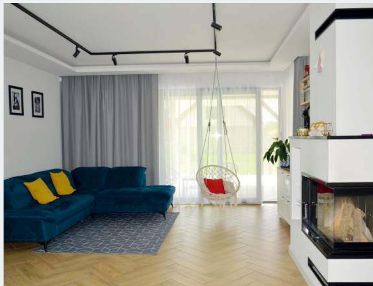
❗ Okno tarasowe HS trzeba było obniżyć do poziomu posadzki.
