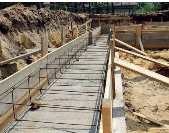
🔧 Zbrojenie ław fundamentowych przygotowane do zalania betonem. J. WERNER
