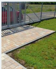
➤ Obrzeża wykonano z gotowych krawężników (osadzono je na zaprawie cementowej).
