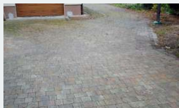
Podjazd i miejsca parkingowe (100 m 2 ) wykończono dwuwarstwową kostką betonową.
