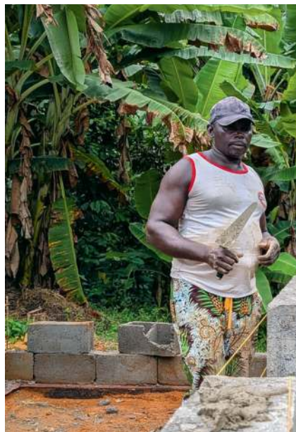
Mężczyźni szkolą się również w stawianiu budynków.
