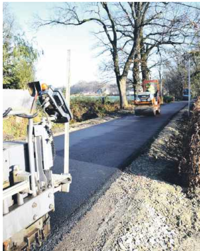
Ul. Miła w Malinie w trakcie przebudowy
