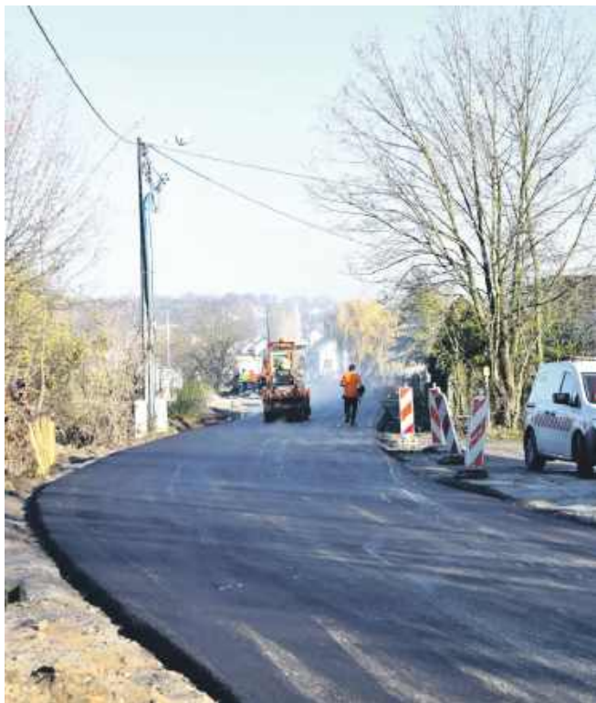
Trwają prace nad nową nawierzchnią ulicy Szkolnej w Wiszni Małej
