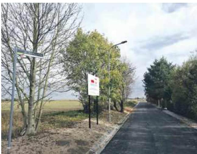
Zakończono przebudowę ulicy Jałowcowej w Ozorowicach
