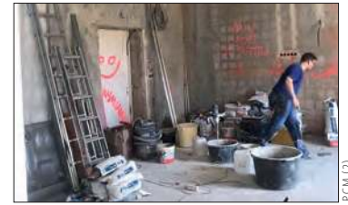
Jedno z kilku miejsc w szpitalu, gdzie prowadzone są prace remontowe
