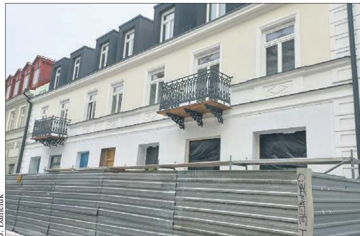
Przebudowywana kamienica przy ul. Grodzkiej 8
