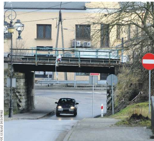
Wiadukt kolejowy nad ul. Krakowską w Chrzanowie
