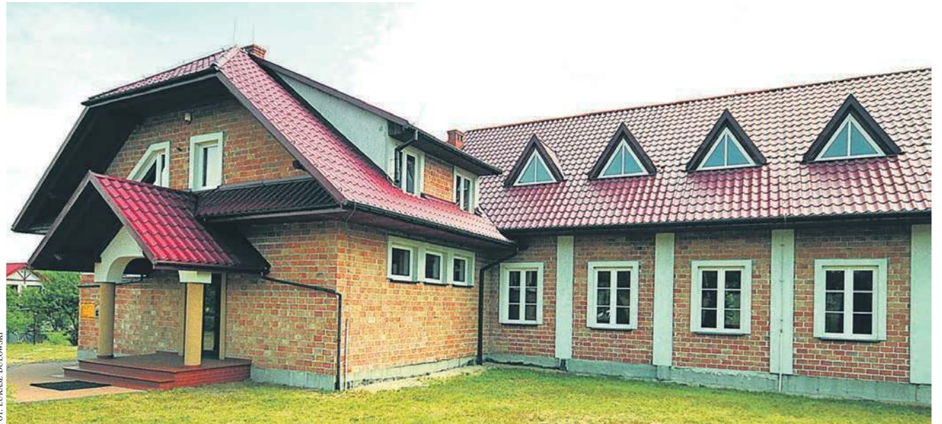
Budowa Domu Ludowego w Mirowie została dofinansowana z funduszy unijnych
