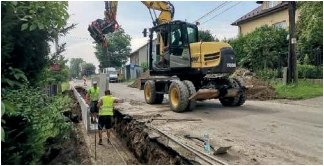
Przebudowa ul. Chrzanowskiej w Balinie
