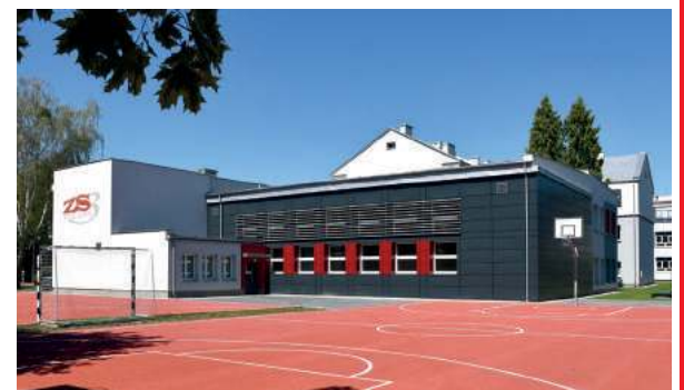
Budynek Zespołu Szkół nr 3 w Puławach po termomodernizacji
