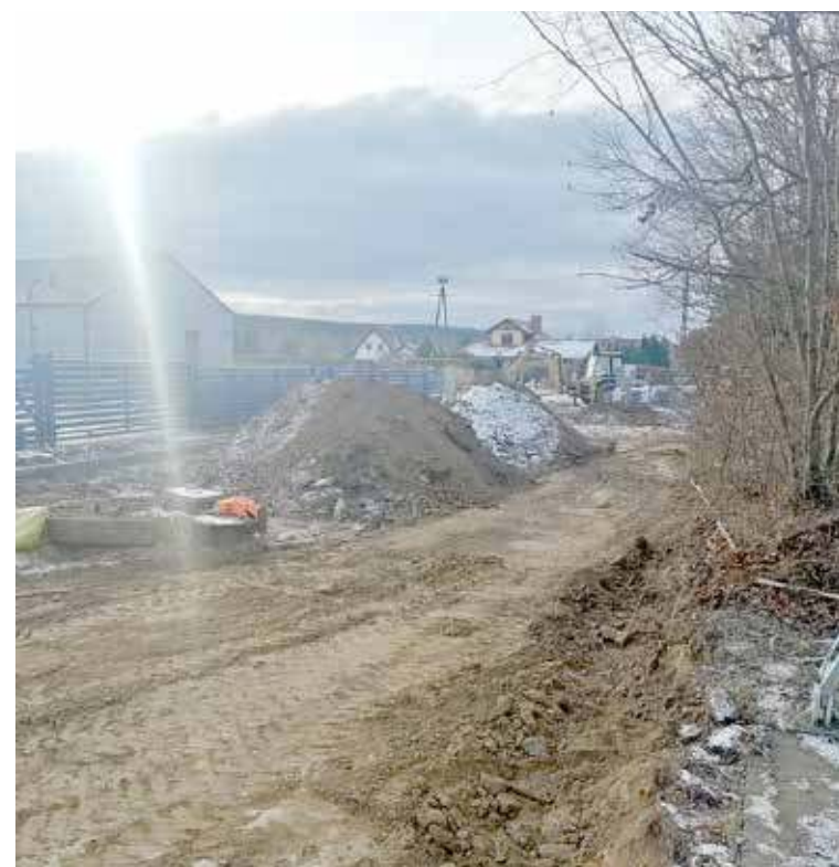
Prace ziemne przy budowie parkingu i drogi trwają mimo niesprzyjającej aury, firma ma bowiem tylko kilka tygodni do zakończenia robót
