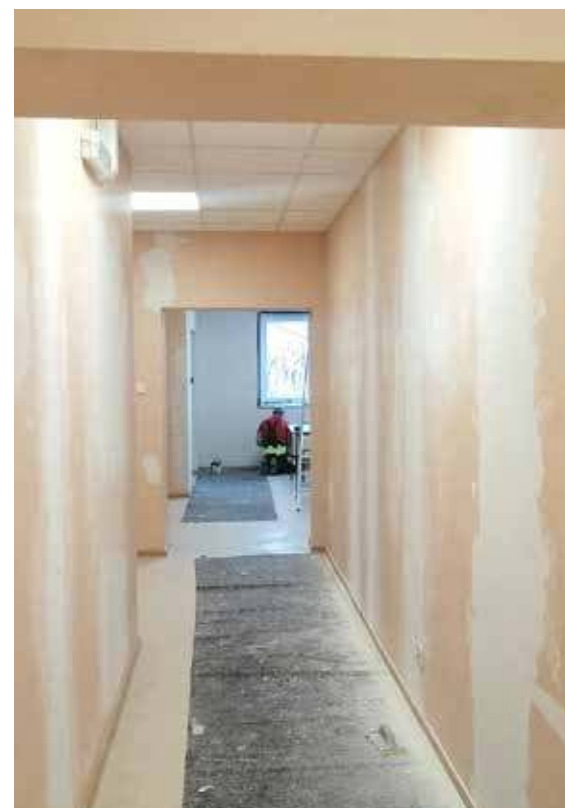
Szpachlowanie i malowanie- trwa odświeżanie wnętrza Urzędu Gminy
