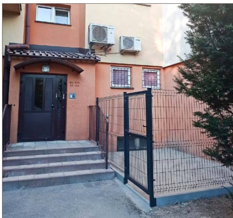
Teren został ogrodzony. Będzie tam dodatkowy przyłącz prądu.
