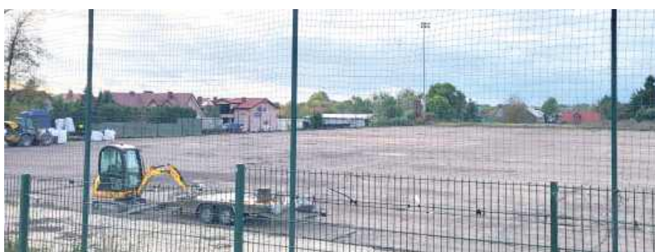
Remont przechodzi bowiem boisko ze sztuczną nawierzchnią znajdujące się tuż przy stadionie przy al. Jana Pawła II. Dotychczasowa murawa była już bardzo wysłużona
