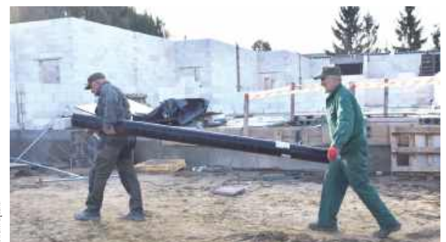
Pracownicy Łęczyńskiej Energetyki kładą kanał ciepłowniczy
