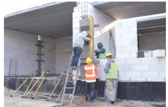
Wykonane zostały już piwnice, a obecnie na budowie uwijają się murarze
