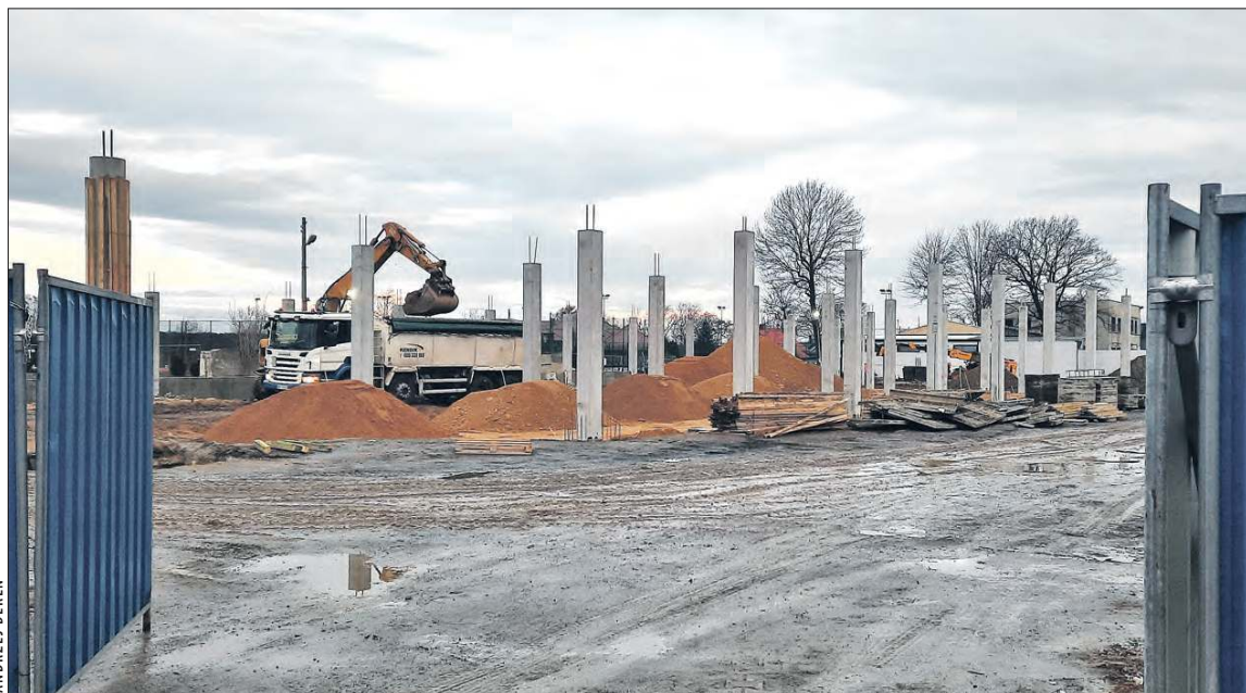
Na placu budowy stoją już słupy konstrukcyjne budynku
