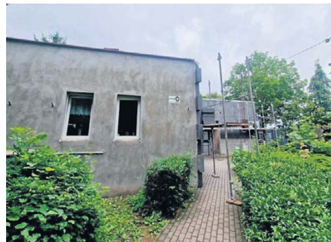
Trwają prace przy termomodernizacji Przedszkola w Wiatrowie.
