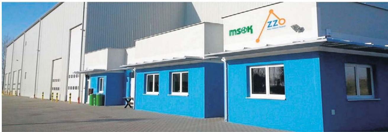
Zmiany w zarządzie spółki Międzygminnego Składowiska Odpadów Komunalnych w Kopaszynie.
