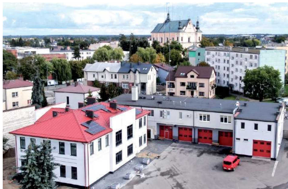
Nowy budynek (po lewej) dla KP PSP Łuków jest już prawie ukończony (fot.KPP Łuków)
