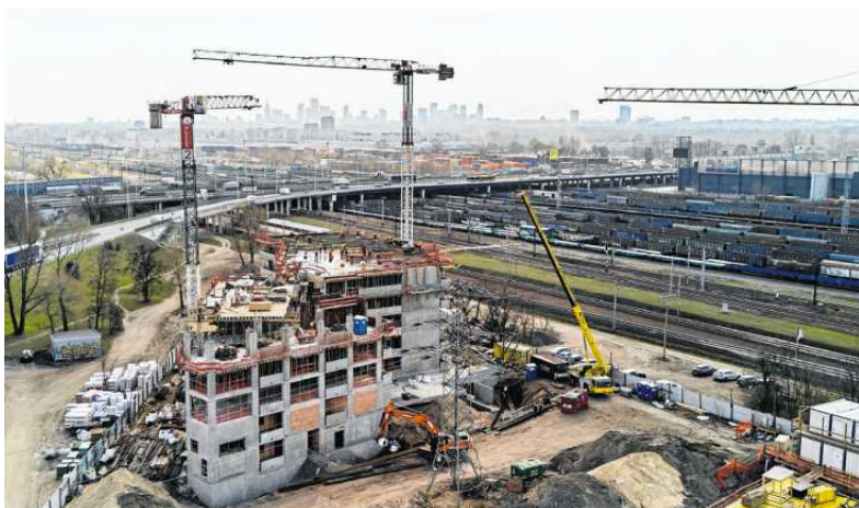
• Budowa osiedla przy estakadzie Trasy Toruńskiej
