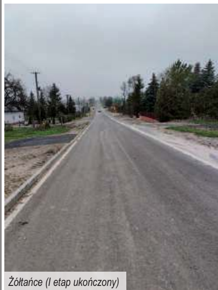
Żółtańce (I etap ukończony)
