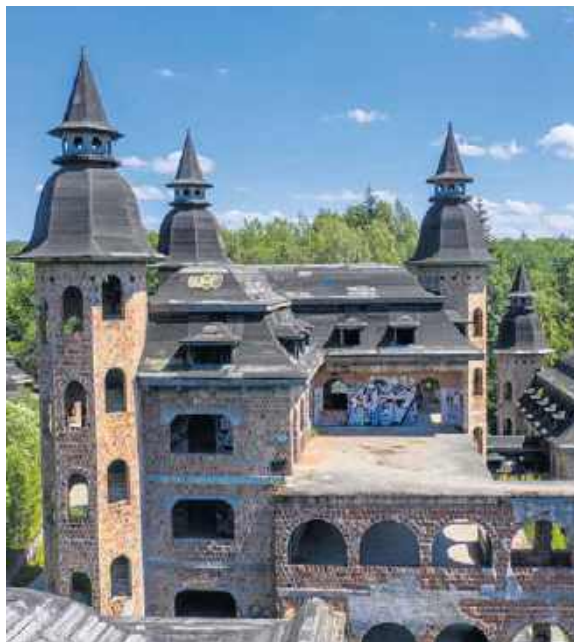
Zamek w Łapalicach - potężna ruina
