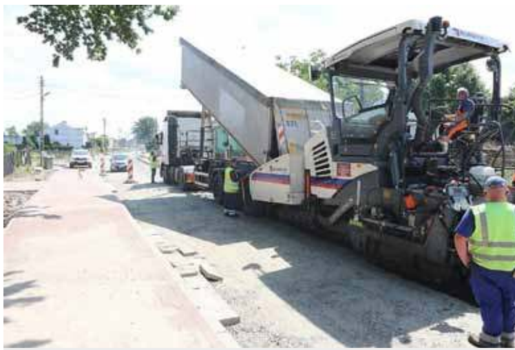
To m.in. na pokrycie wkładu finansowego na budowę głównej ulicy w Lubczynie gmina Goleniów zamierza wydać część pieniędzy z FIL
