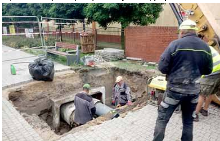
Pracownicy goleniowskiego PEC sprawdzają fragment ciepłociągu, tak by nie zawiódł on zimą
