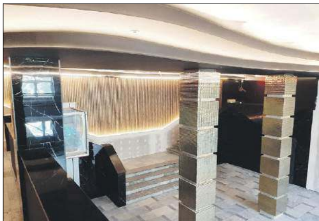
W kinie Sława trwają już ostatnie prace, związane z montażem kinotechniki. Być może jeszcze w tym roku widzowie zasiądą w kinowych fotelach
