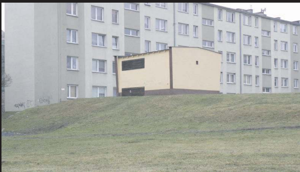
Charakterystyczna skarpa jest pozostałością po dawnych bastionach przy obecnej ul.3 Maja
