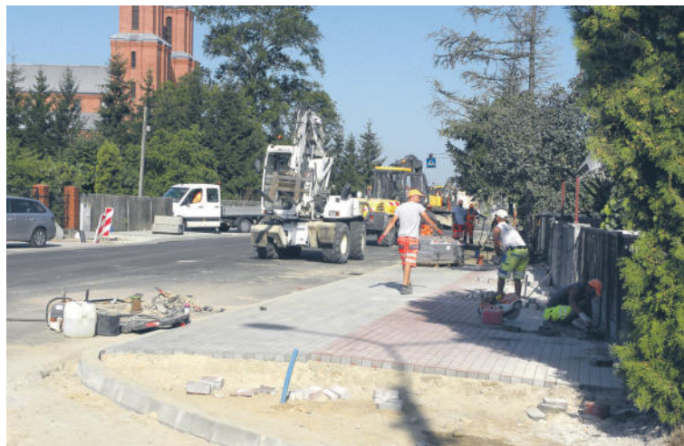
Prace na ul. Popiełuszki
