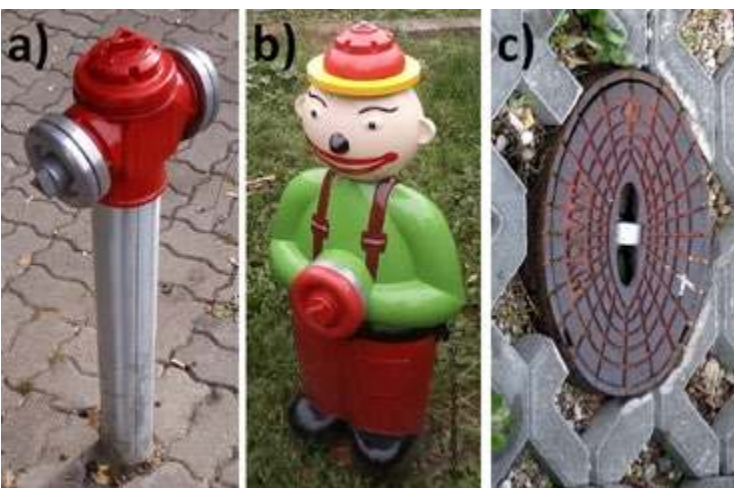
Fot. 5. Hydranty nadziemne (a, b) oraz podziemne (c) umożliwiające czerpanie wody do celów przeciwpożarowych.
