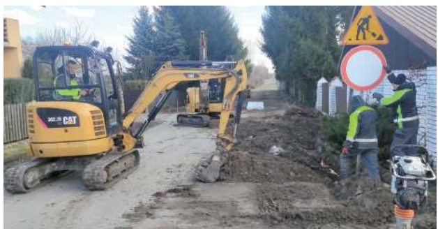
Prace na budowie i przebudowie ul. Orzeszkowej
