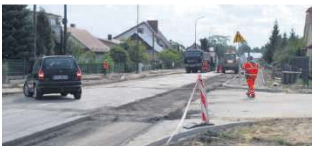
Radni podkreślili, że drogi o znaczeniu strategicznym dla miasta i powiatu wymagają remontu.
