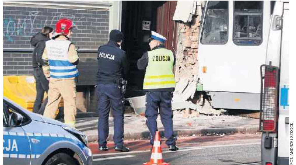
Siła uderzenia była bardzo duża. Zniszczona jest brama wejściowa kamienicy oraz część elewacji. Uszkodzony została też tramwaj, który trzeba było odholować do zajezdni
