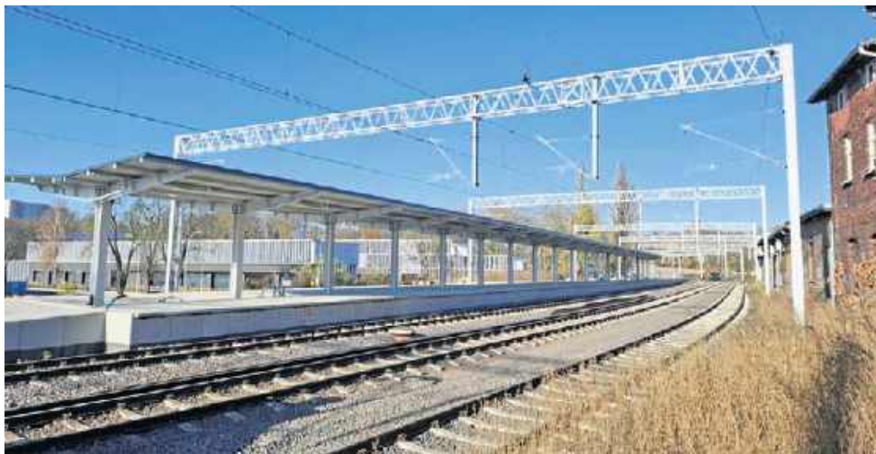
Szczecin Turzyn. Zadaszenie peronu, powstają też nowe schody dla pieszych
