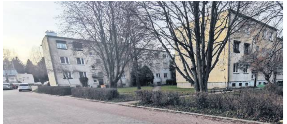
Na największym osiedlu w Borku Strzelińskim pojawił się problem z ciepłą wodą i ogrzewaniem
