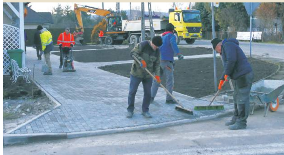
Wykonawcą remontu chodnika przy ul. Szkolnej w Przewornie była firma Tomasz Bartków z Przeworna
