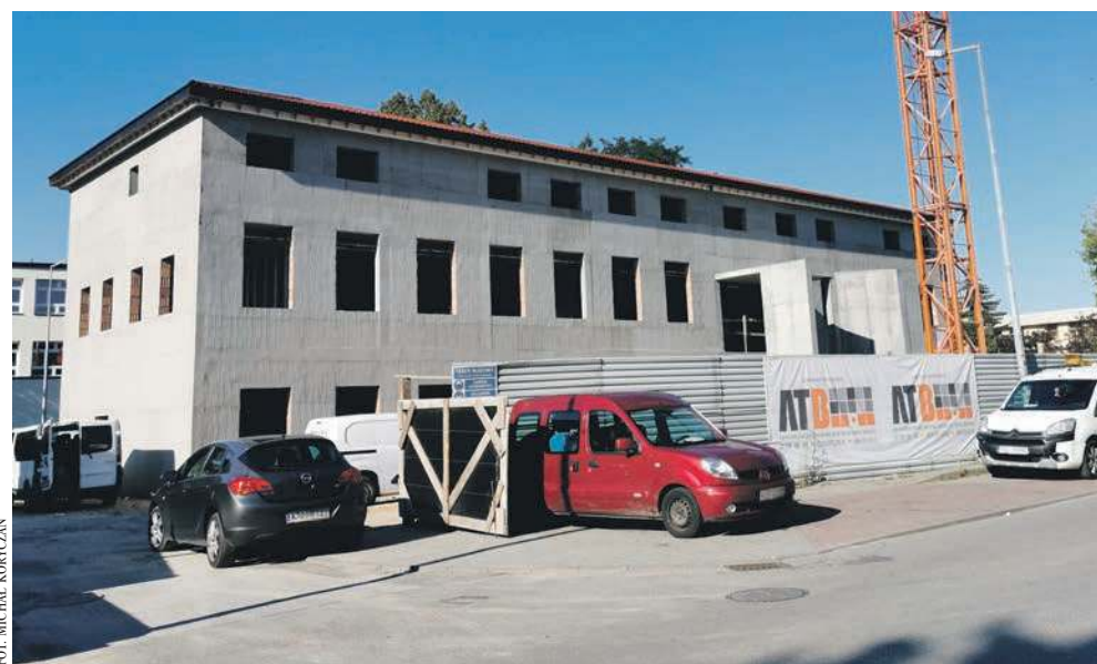
Trwa budowa nowej biblioteki w Krzeszowicach
