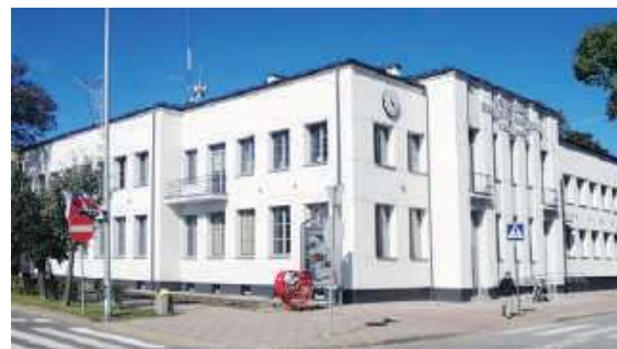
Budynek Urzędu Miasta Hrubieszów oraz Starostwa Powiatowego.
