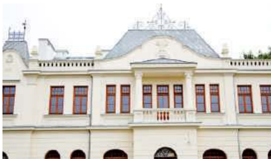
Budynek Hrubieszowskiego Centrum Dziedzictwa.
