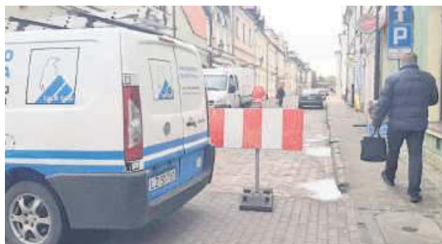
Ulica Staszica formalnie jest już placem budowy.
