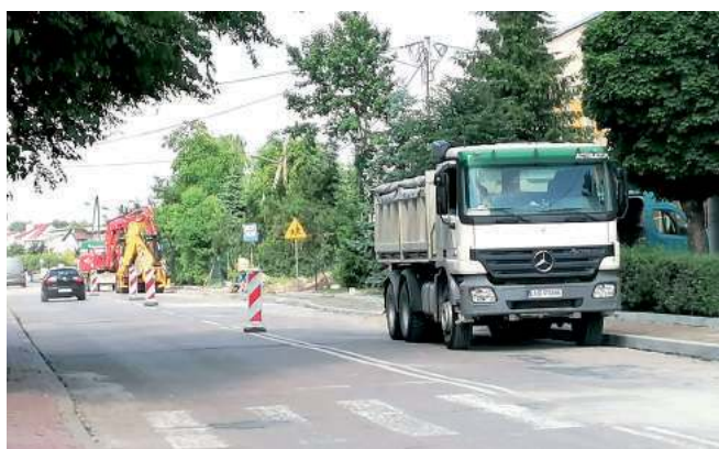
W tym tygodniu na ul. Partyzantów pojawić ma się druga firma, która wymieniać będzie starą sieć wodociągową zlokalizowaną po lewej stronie ulicy
