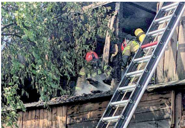
Po ugaszeniu pożaru strażacy usunęli spalone elementy więźby dachowej i dokładnie sprawdzili wszystkie pomieszczenia
