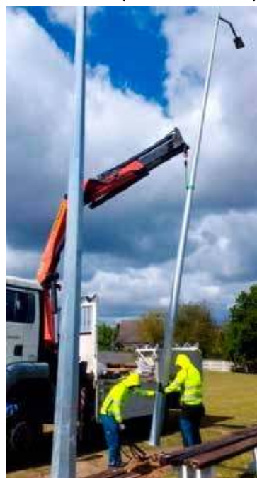
Montaż słupów stalowych
