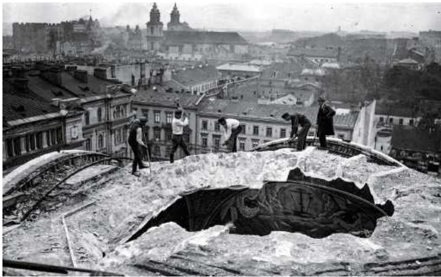
Rozbiórka soboru św. Aleksandra Newskiego.
