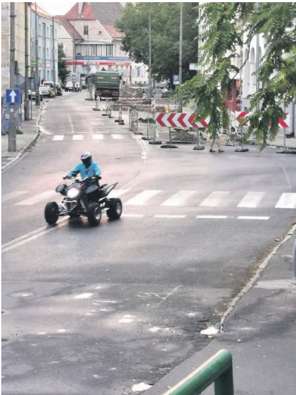
Remont ul. 1 Maja zakończy się w listopadzie, natomiast prace w Rynku pod koniec roku. Wymiana nawierzchni na skrzyżowaniu za mostem na Odrze potrwa do końca sierpnia, ale związane z tym utrudnienia w ruchu tylko do końca lipca
