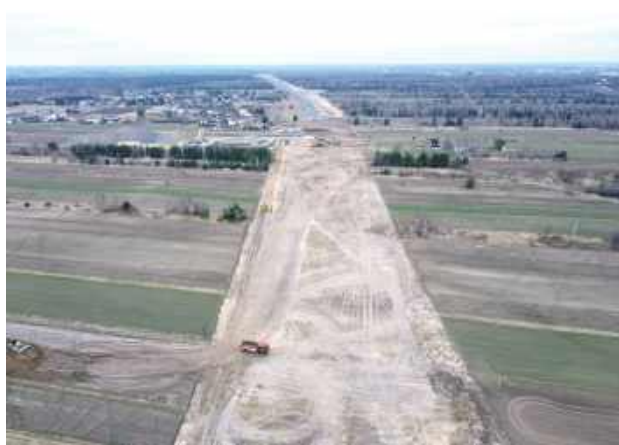
Budowa S19 Lubartów - Lublin. Marzec 2025 r.
