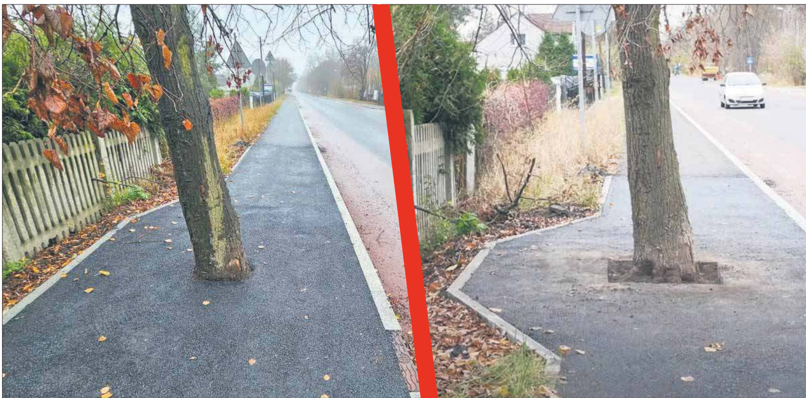
Drzewo po zaasfaltowaniu i po dokonanych poprawkach
